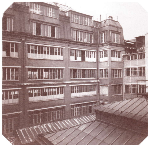
Vue intérieure de l'ancien bâtiment.
